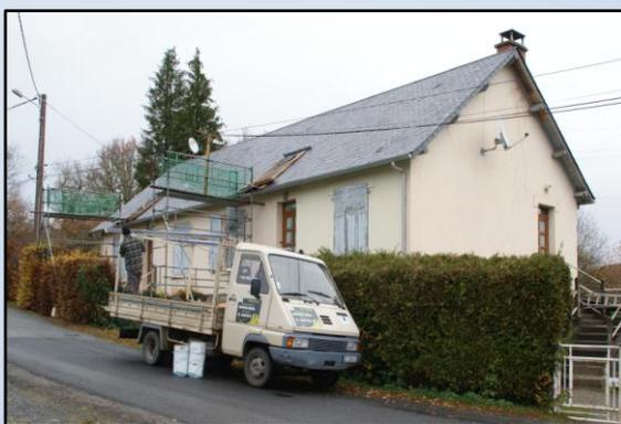
✓ Ravalement de façades des logements n° 7 et 8 : C'est l'entreprise TOURNADRE (Bort les Orgues) qui a assuré ce chantier. Avant l'application des peintures, elle a procédé au lavage haute pression des façades et dessous de toit, nettoyage et ponçage des persiennes et gardes corps. Le montant des travaux est de 18 617,16 € TTC.
